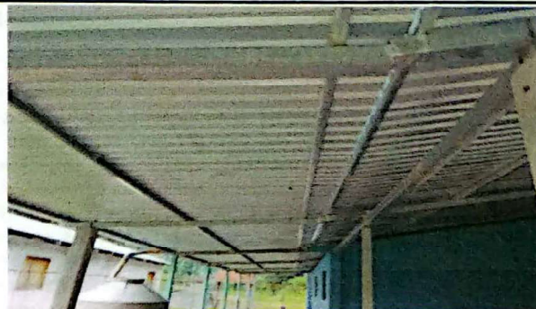
Foto 2: ESTRUCTURA DEL TECHO DE TECHO
