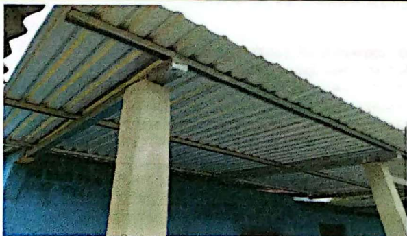
FOTO 1: CUBIERTA DE LAMINA
